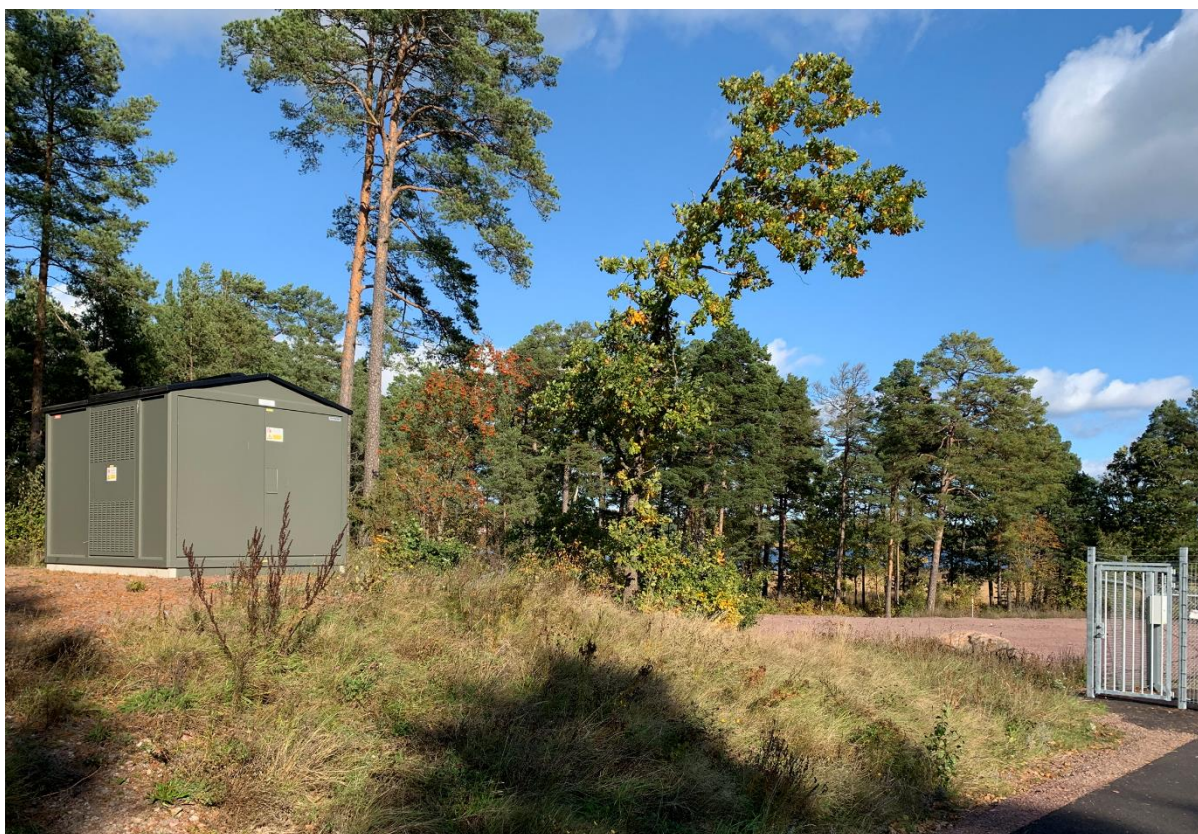
Bilden visar transformatorstationens läge mot Verksvägen, med den avverkade uppgrusade ytan nedanför åsen som syns till höger i bild.
