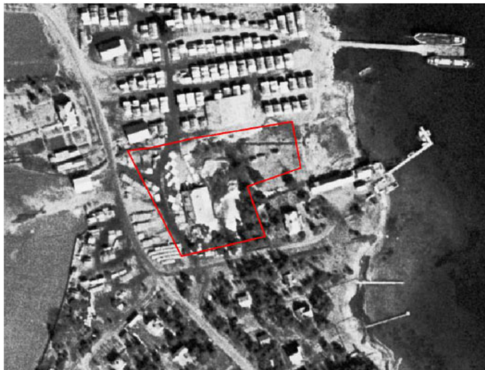
Flygfoto från 1957 över provtagningsområdet, visar en byggnad och trälagring på området, miljöteknisk markundersökning 2023, Kartunderlag: © Lantmäteriet
