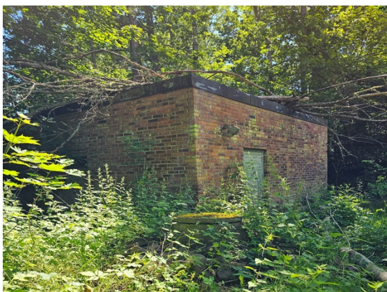
Figur Det gamla pumphuset
