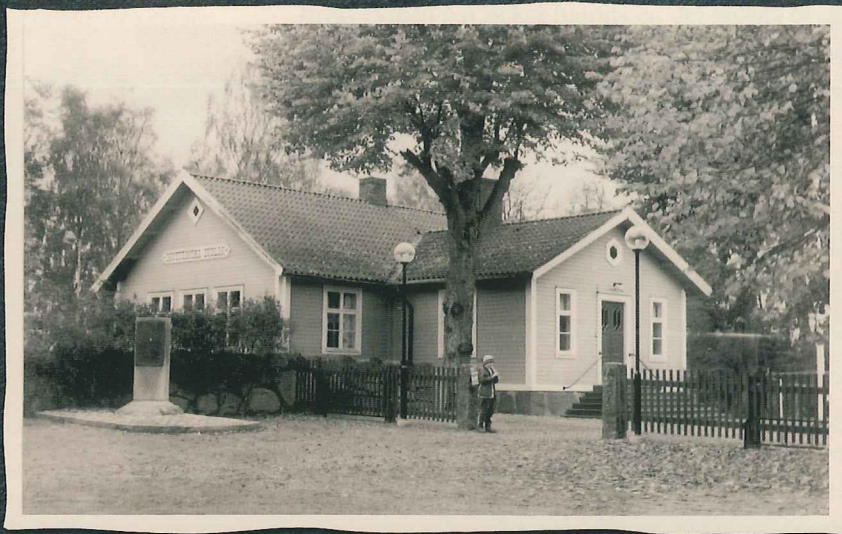
Den äldsta av skolbyggnaderna vid Skytteanska skolan, byggnadsminne enligt KML
