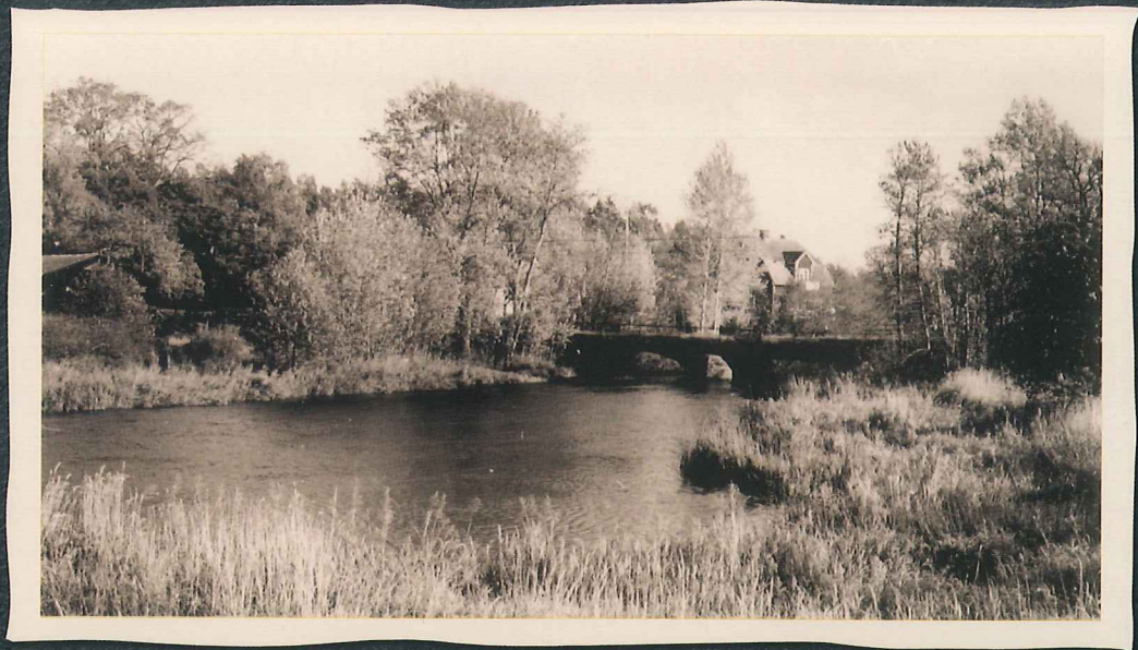
Emån och den delvis raserade stenvalvsbron vid Högsrum
