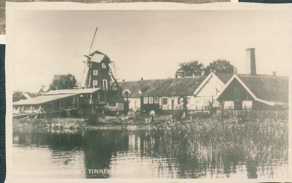
Den första sågansfabriken i Timmernabben med väderkvarn av "Skånetyp", byggd på platsen 1865. Fabrikören var dansk, vilket kanske förklarar byggnadstekniken - korsvirke.
